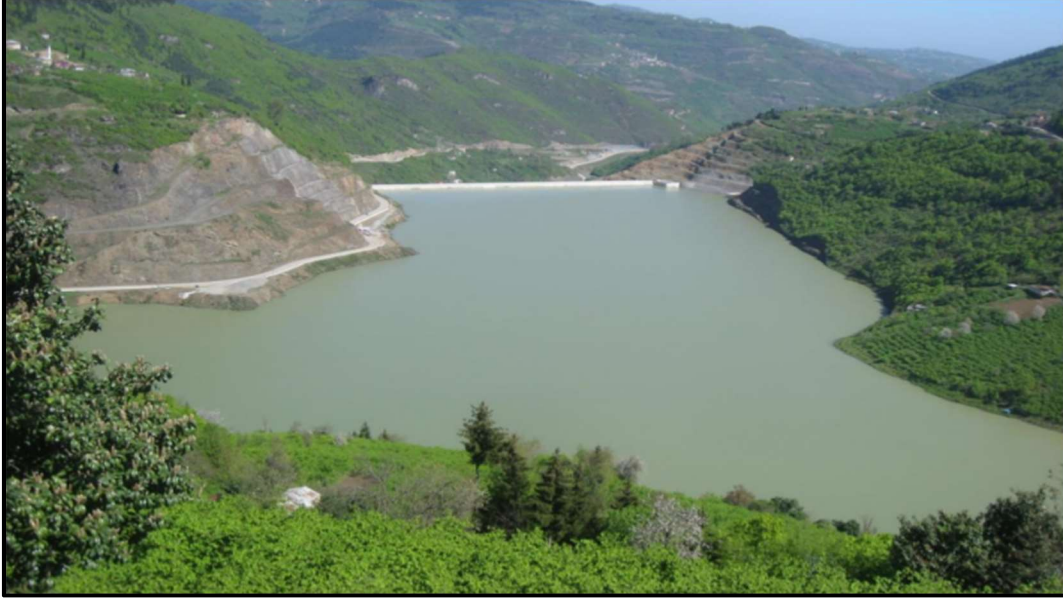
Şekil 1.8: Trabzon İli Atasü Barajı ve HES İnşaatının Genel Görünümü. (DSİ 22. Bölge Müdürlüğü, 2021)
