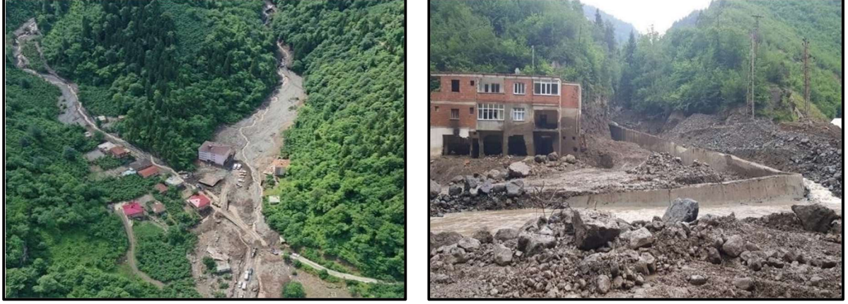
Şekil 1.22: Trabzon Araklı İlçesi, Çamlıktepe Mahallesi'nde Meydana Gelen Sel/Su Baskını, Heyelan Afetleri (18 Haziran 2016). (AFAD Trabzon, 2021)
